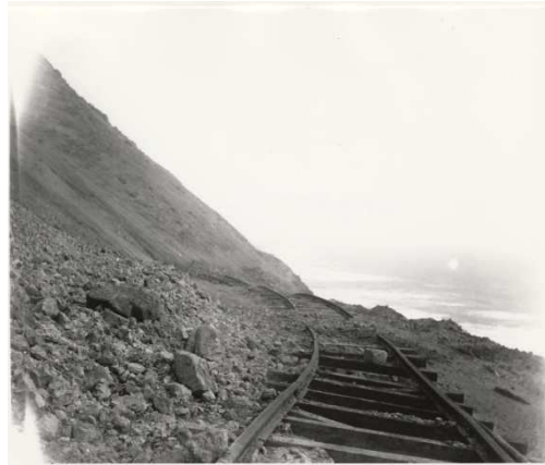
شکل ۱-۴- تصویر وقوع سنگریزش بر روی خط آهن
