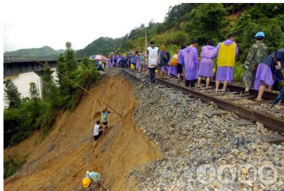
شکل ۱-۳- تصویر وقوع زمین لغزش در خط راه آهن
